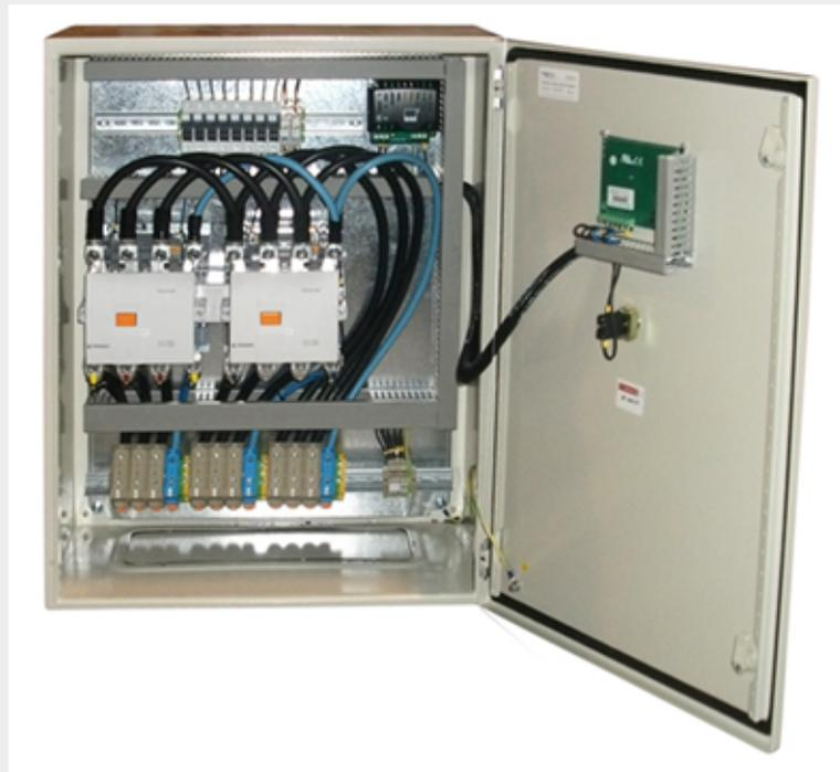
Cuadro compuesto por la central electrónica que detecta el fallo de red y de 2 contactores con enclavamiento mecánico y eléctrico o contactos de conmutación motorizados, controlados por dicha central y que realizan el cambio de suministro GRUPO o RED a la carga.”
